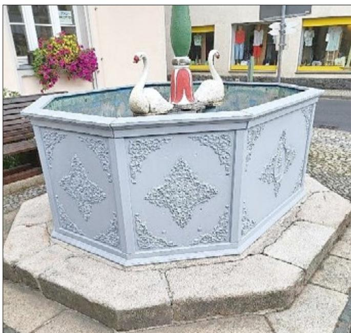
Dieses Bild, aufgenommen am 26. Juli 2022, zeigt, die alte Farbe ist bereits entfernt und eine Grundierung ist aufgetragen.
